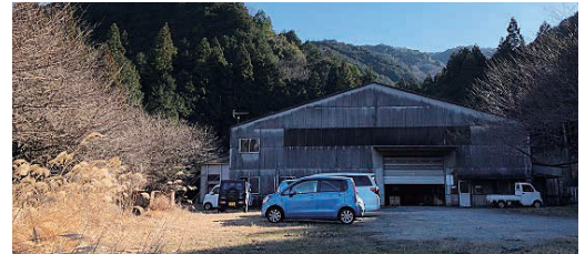
▲ 新規採用が困難な条件不利地域に立地する岐阜支社 (事務所、倉庫、検査・組立等のスペースがある)
