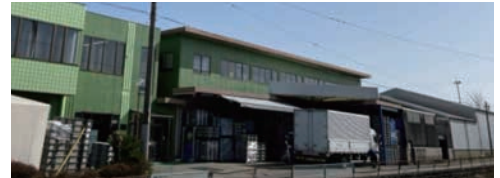
▲1日800～1,000品番の納入指示(かんばん)に対し、翌日出荷できる現場力、生産管理能力、デジタル変革力を有する本社工場
