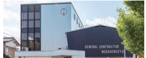
▲グループとして建築、建設など多様な部門を持ち、「よりよい生活環境」を実現する全ての機能を有する。
